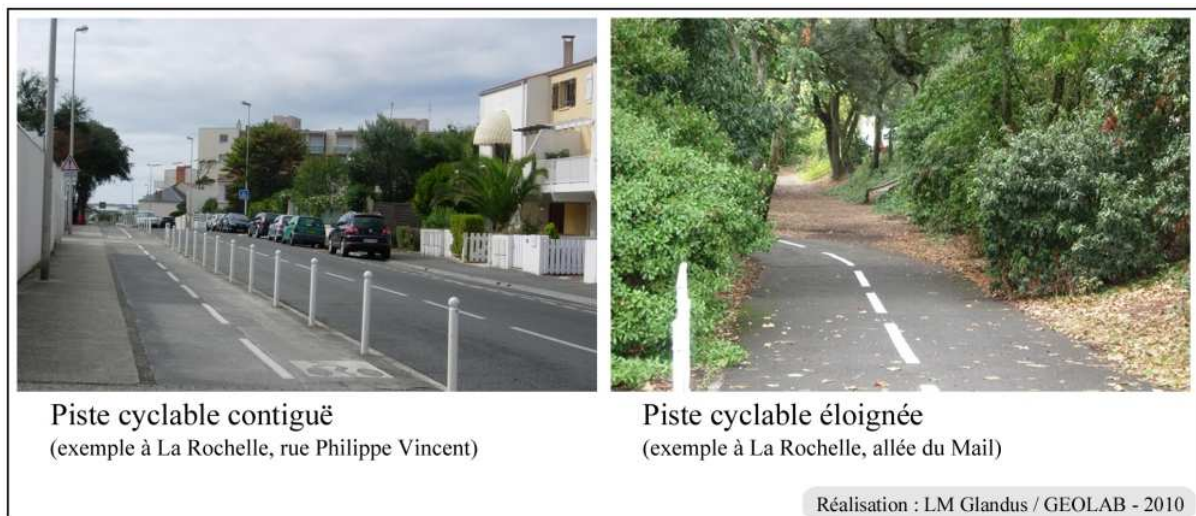
Figure 107 : Exemples de pistes cyclables, éloignées ou non des voies de trafic (Photos : LM Glandus)
