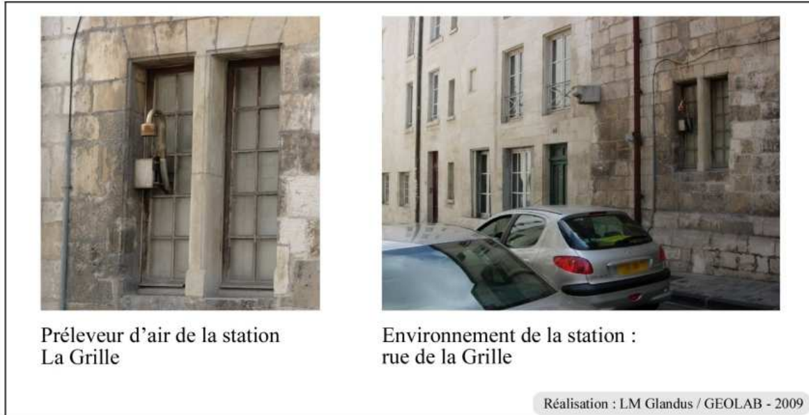
Figure 23 : Station trafic La Grille de La Rochelle
