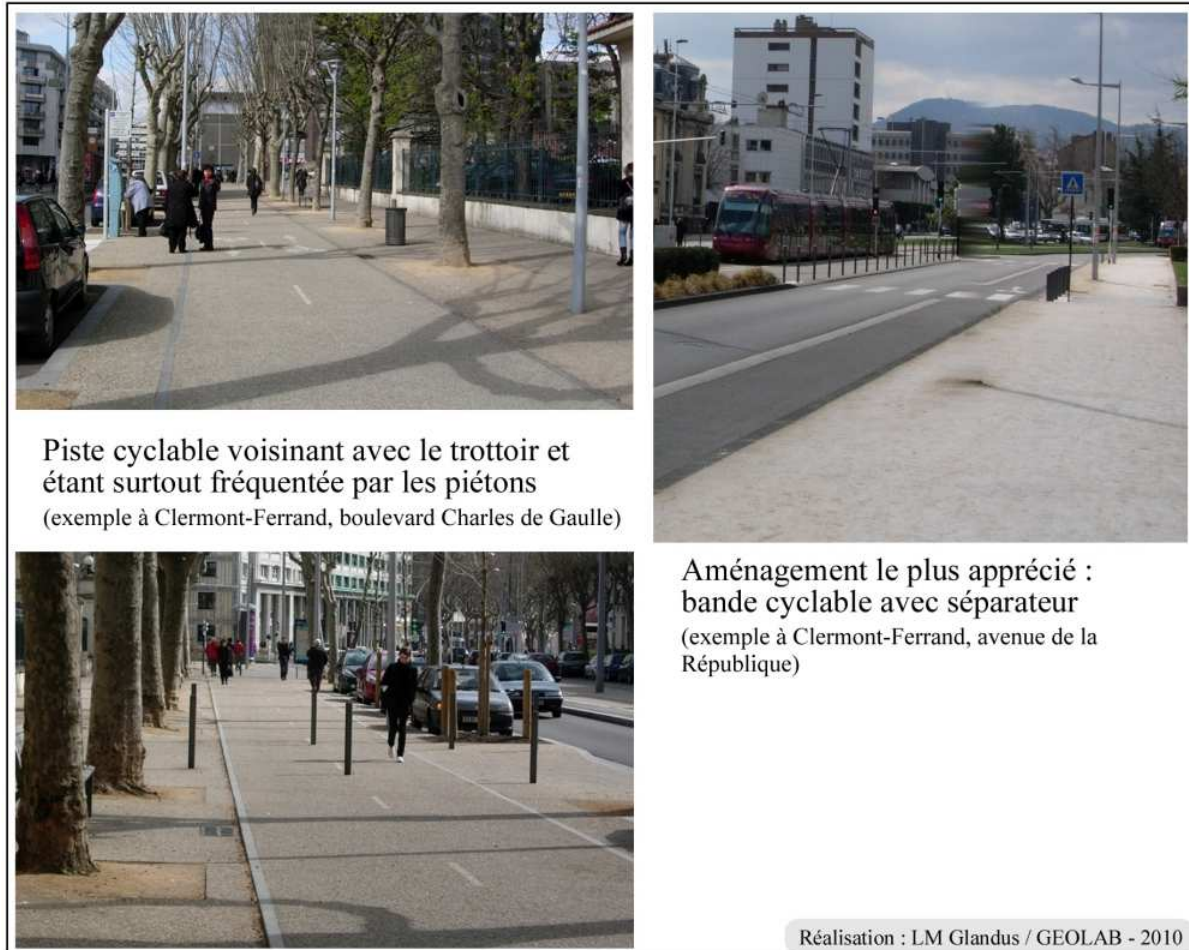
Figure 111 : Des aménagements cyclables plus ou moins adéquats (Photos : LM Glandus)
